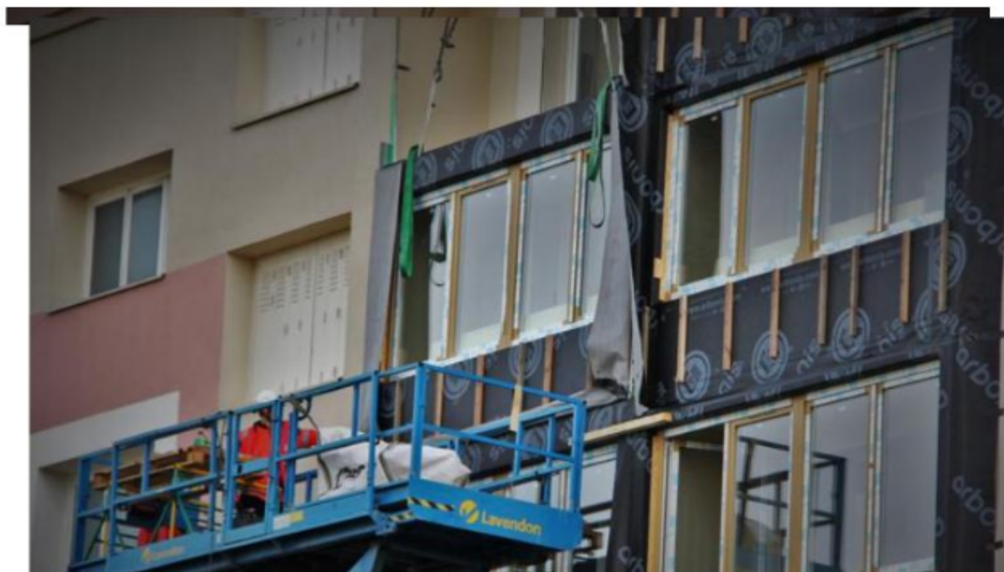
L'isolation par l'extérieur peut permettre d'effectuer le ravalement en même temps. Photo Fabien HISBACQ
